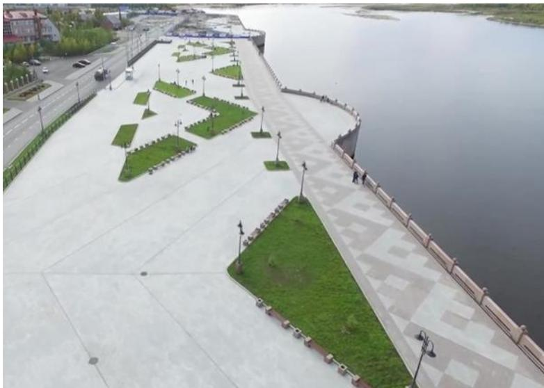
Это целый комплекс сооружений, включающий подпорную стенку из металлического трубчатого шпунта, гранитные ограждения с декоративными вставками, лестничный сход к воде, смотровые площадки, покрытую гранитом прогулочную зону, освещение, систему
